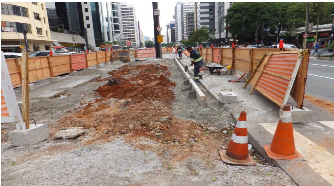
Vista do atual estado da obra no trecho da Av. Paulista, proximidades da Av. Brig. Luis Antonio.
