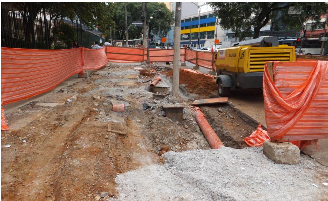
Vista do trecho em obras na calçada da Av. Bernardino de Campos (sentido Paraíso), proximidades da R. Treze de Maio.
