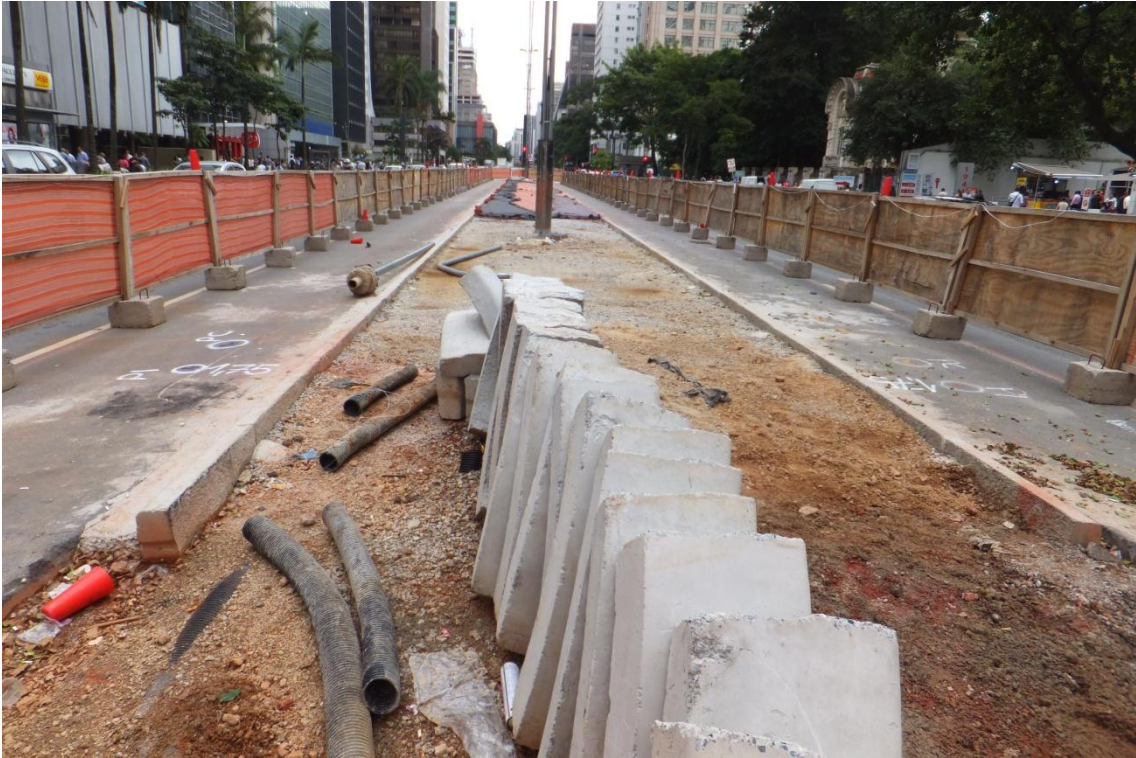
Vista do estado atual da obra no trecho da Av. Paulista, proximidades da R. Padre João Manoel.
