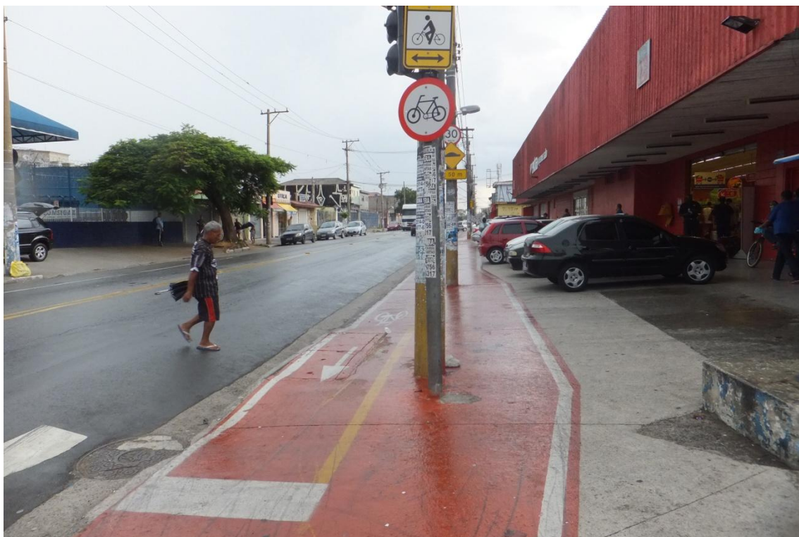
Vista da ciclovia da Av. Oliveira Freire, proximidade da R. Ascenso Fernandes, obstruída por poste e sem espaço para circulação de pedestres.
