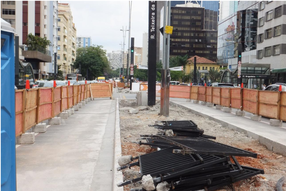
Vista do atual estado da obra no trecho da Av. Paulista, proximidades da R. Carlos Sampaio.
